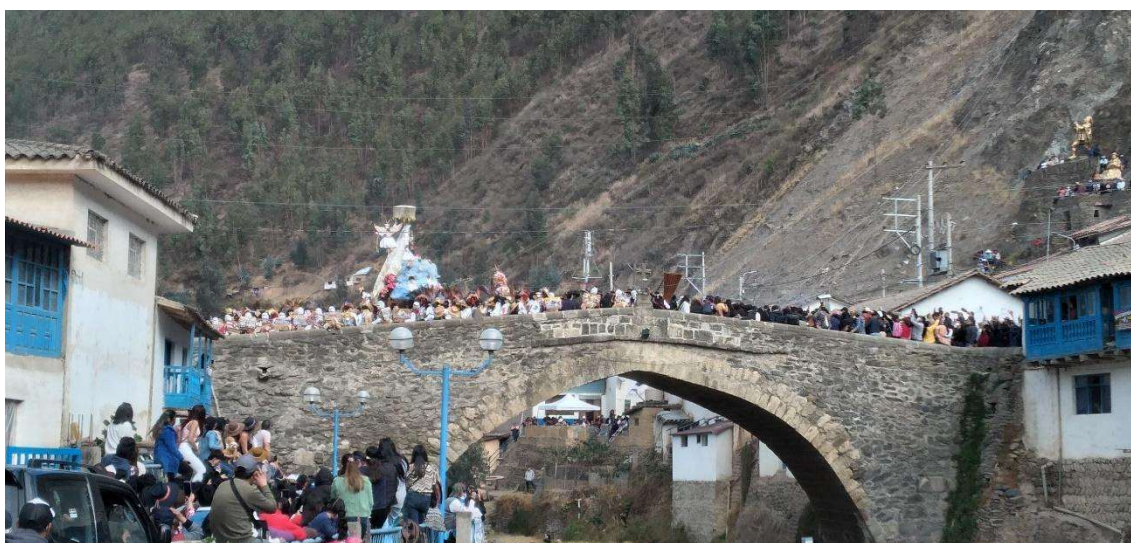
Figura 1. Puente Carlos III . Fotografía tomada por el autor.
