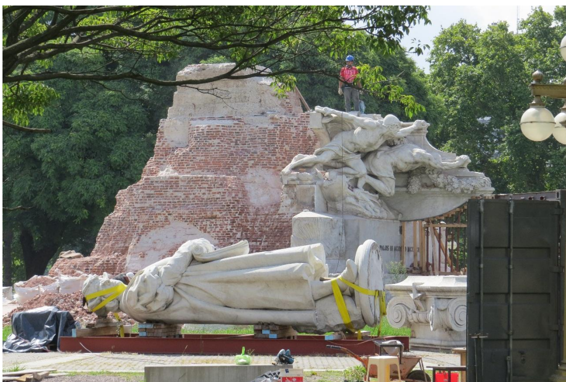
La escultura que representa a Cristóbal Colón acostada, en febrero de 2014. Detrás el basamento en demolición, dejando a la vista la mampostería que conformaba la cripta.
