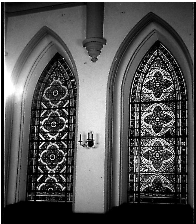
Fig. 4. Muro lateral con vitral instalado en 1912
